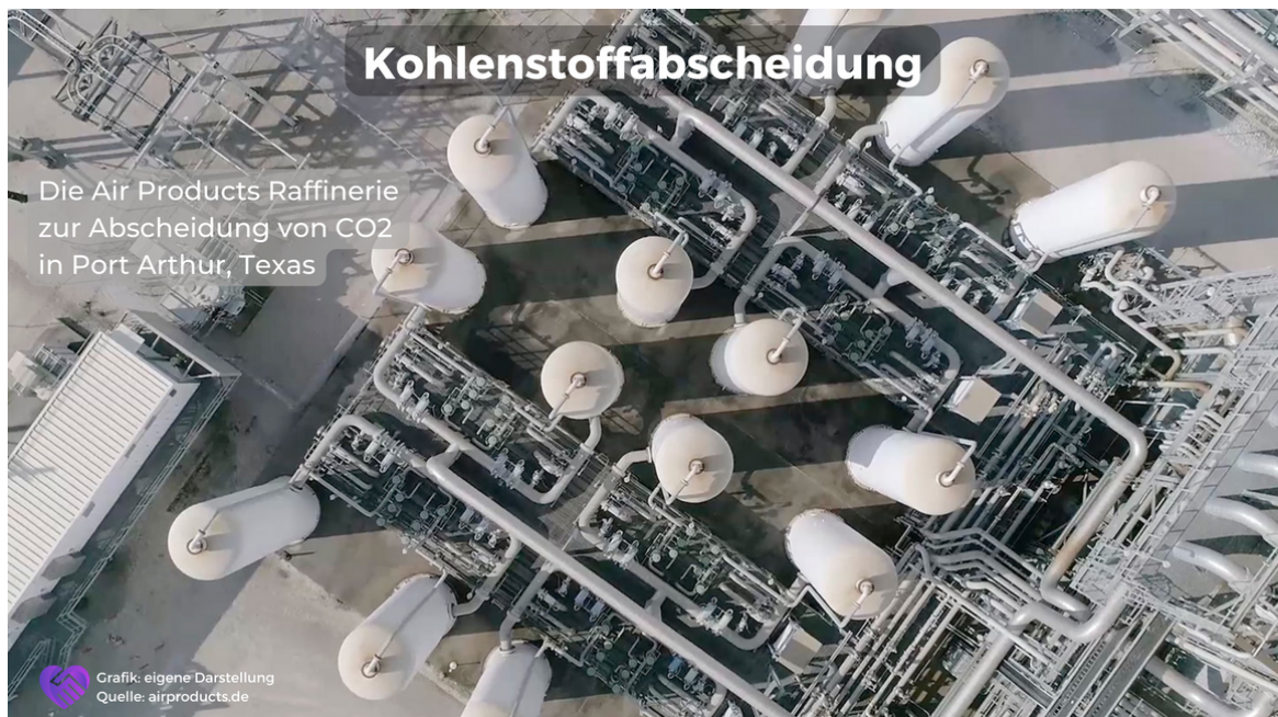
Abb. 8: Abschneidung, Nutzung und Speicherung von Kohlenstoff im großem Maßstab – die Dampf-Methan-Reformer-Raffinerie in Port Arthur, Texas bindet eine Millionen Tonnen CO 2 pro Jahr.
